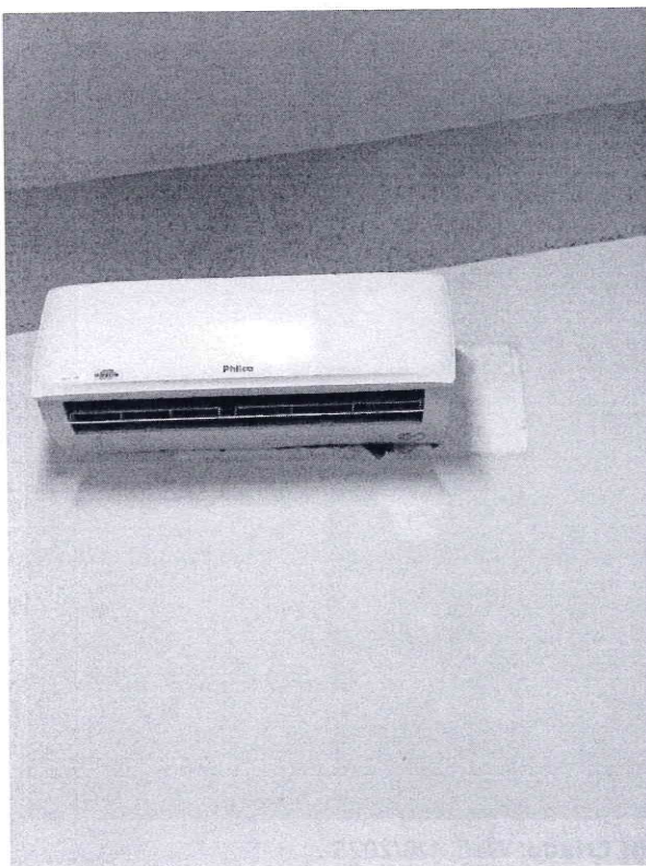
(83) Criado: Wed, 1/8/2025 Comunicação- pintura da parede danificada
