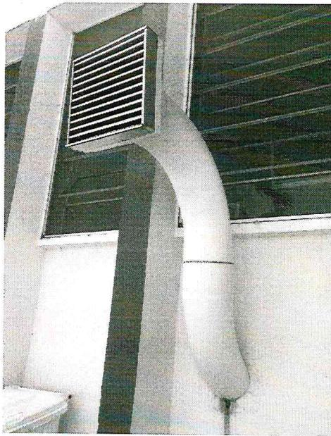
Figura 02: Duto de saída de ar filtrado para ambiente externo.
