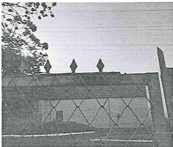
Foto 02 – Portão da Central de Resíduos
