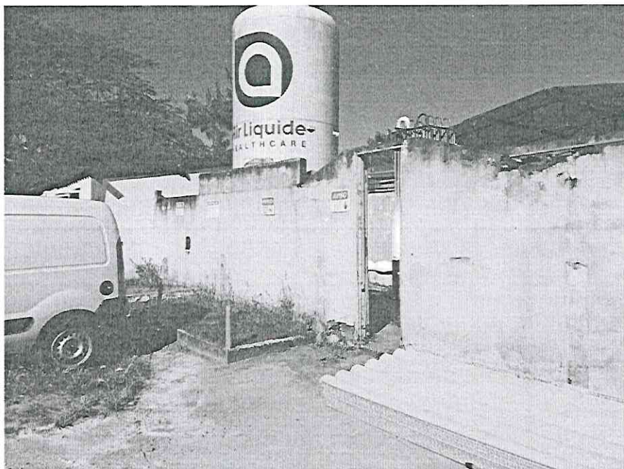
Foto 05 – Muro de fechamento da Central de Gás
